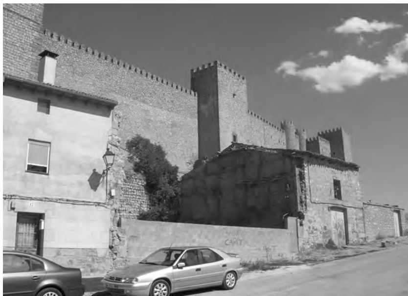
Figura 18. Casas de la calle Puerta Nueva, delante de la muralla occidental (fotografía de la autora).
