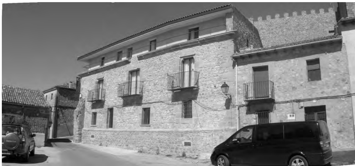
Figura 16. Vivienda situada en el nº 2 de la calle Castillejo, esquina con la calle Puerta Nueva, situada adyacente al castillo (fotografía de la autora).
