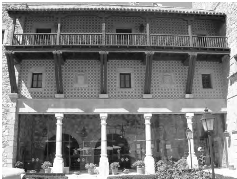
Figura 15. Solana sobre jabalcones en muro interior norte, decorado con esgrafiados (fotografía de la autora).
