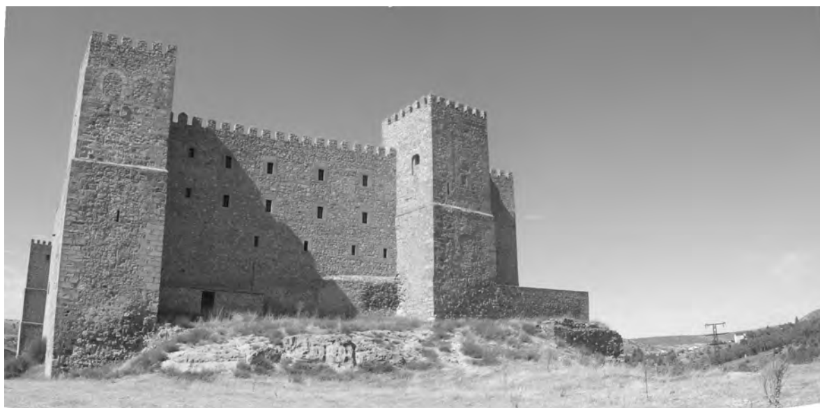
Figura 12. Fachada sur del castillo, en la que se aprecian huecos cegados (Fotografía de la autora).
