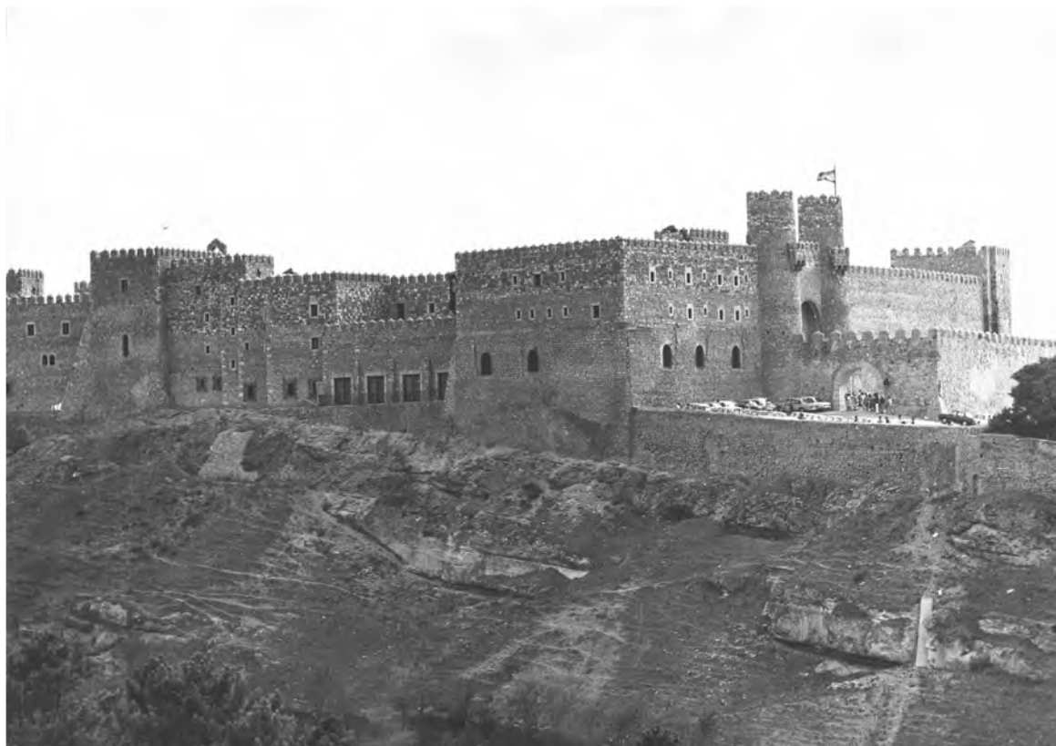
Figura 7. Solución final ejecutada en el alzado oriental, en el que se eliminó la cubierta a cuatro aguas del volumen del extremo noreste, que fue íntegramente respetado y se remató su coronación con almenas. Este cuerpo suplió, de forma improvisada, la deseada torre de esquina (ca. 1976) [AITE].
