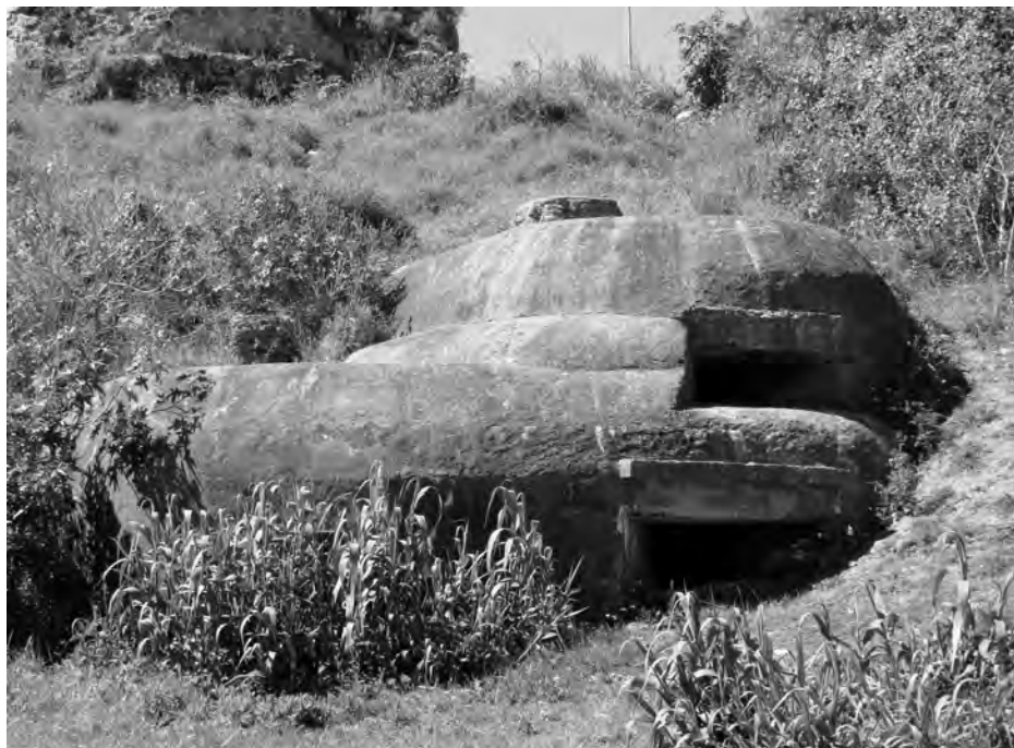
Figura 4. Fortín compuesto 274 de Torre Almirante, en Algeciras.
